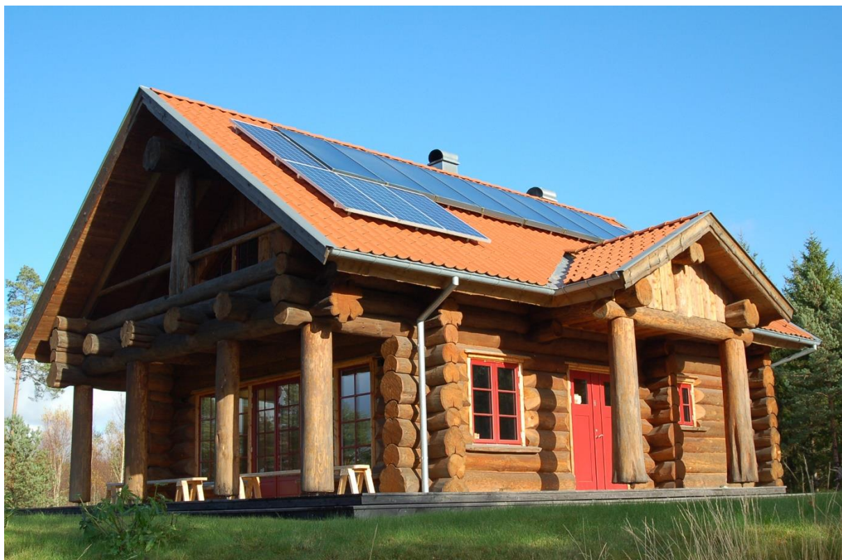
Bild 5 Bilden visar den energiautonoma jaktstuga med konferensmöjligheter som uppförts av Svenljunga naturbruksgymnasium. Huset är inte anslutet till elnätet. Det får sin energi med sol, vind och bioenergi. Under huset finns ett lager av stenmjöl som ansamlar värme under sommarhalvåret och avger värme under den kalla årstiden. El ackumuleras i ett batterilager och distribueras som lågspänning. Foto: Björn Larsson
