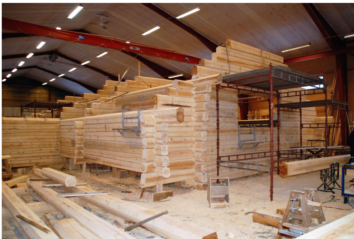
Bild 3 Handtimring av ugnstorkat 20 cm timmer i uppvärmd lokal med travers och arbetsbockar för bra arbetshöjd (nere, till höger). Foto Sven-Gunnar Håkansson. Bilden nedan visar det färdiga huset i uppsatt i den norska fjällvärlden.
