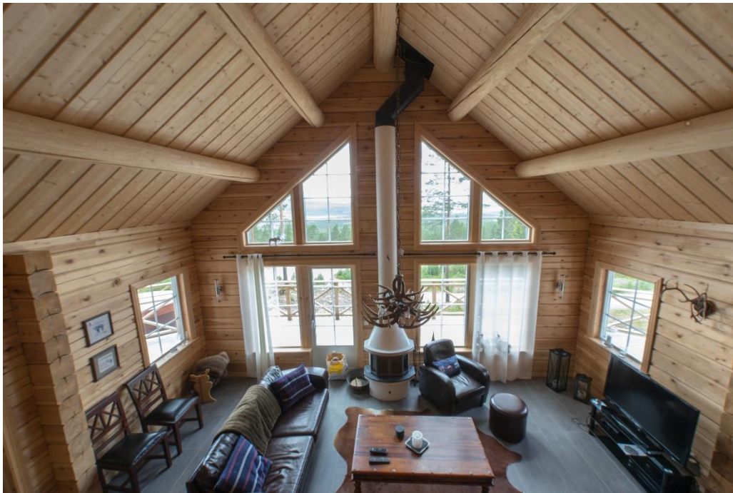
Bild 2 Maskinellt/industriellt tillverkat hus med 20 cm tjocka väggstockar. Foto Christer Lindgren.
